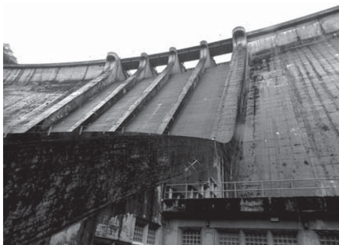
Figura 6. Presa y central de Grandas de Salime (1948-1954), obra de Joaquín Vaquero Palacios, fotografía actual, septiembre de 2012
