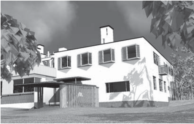
Figura 1. Alzado desde acceso a vivienda
