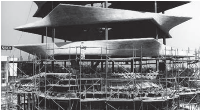
Figura 8. Miguel Fisac. Torre de Laboratorios Jorba . Madrid, 1965-68. Foto de la construcción
