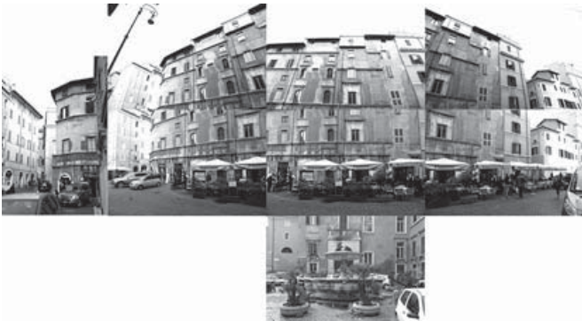
Figura 08. Ex-Piazza di Santa Maria del Pianto, Gennaio 2014, mosaico fotografico del prospetto e della fontana.
